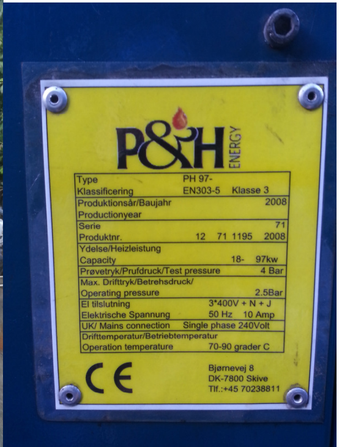
P&H Biobrennstoffkessel , Heizung Typ PH97, BJ 2008, 97 KW für den Einsatz für alle Biomasse-Produkte wie Holzpellets, Getreide, Raps, Dinkelspelz usw.
